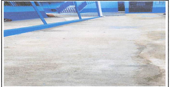
Foto 4: Ampliacion de Pavimento
