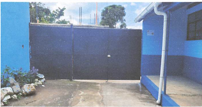
Foto 3: Mantenimiento de Porton
