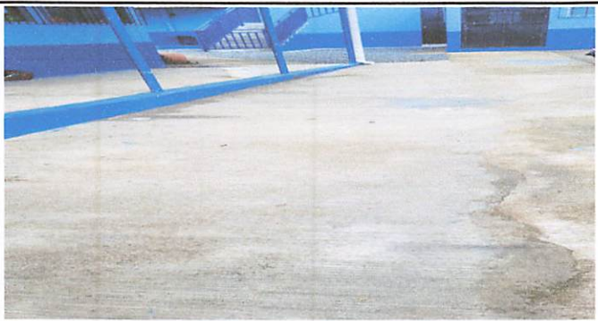
Foto 5: Instalacion de Drenage
