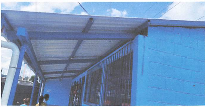
Foto1: Instalacion de Lamina
