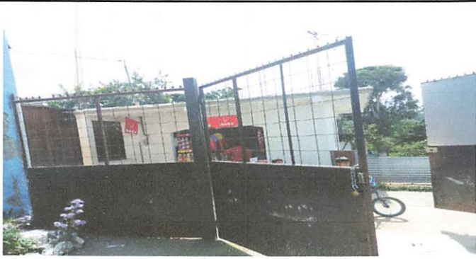
Foto 3: Mantenimiento de Porton
