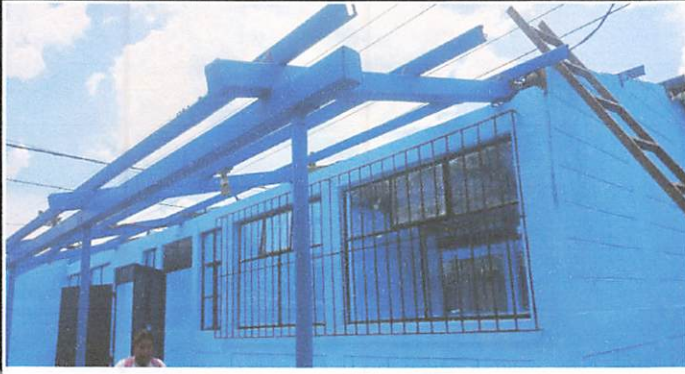
Foto1: Desmontado de Techo
