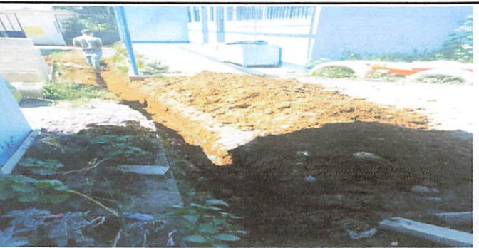
Foto 5: Instalacion de Drainage
