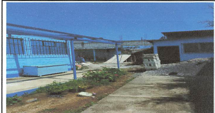
Foto 4: Ampliacion de Pavimento
