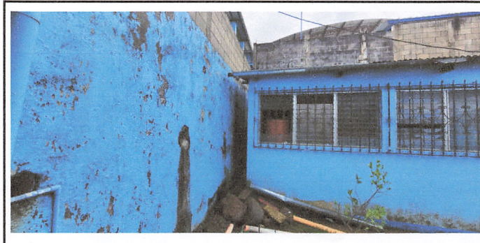
Foto 6: Creacion de Sanitarios
