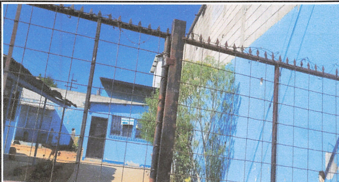
Foto 3: Mantenimiento de Porton
