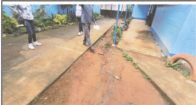
Foto 4: Ampliar de Pavimento
