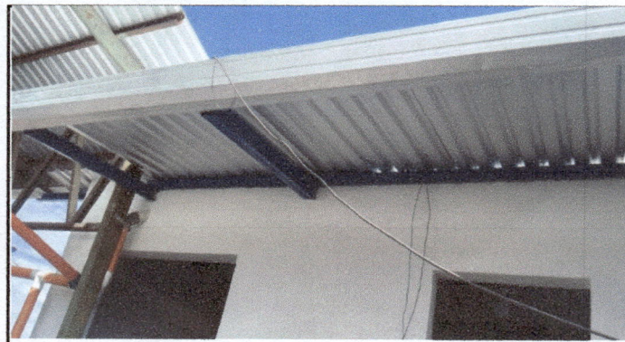
colocacion de laminas, electricidad, elaboracion e instalacion de canales
