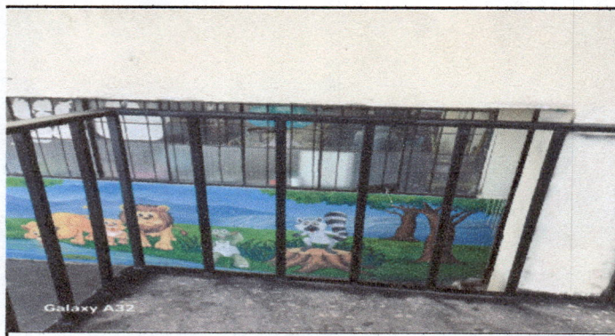
mantenimiento y pintados de barandas
