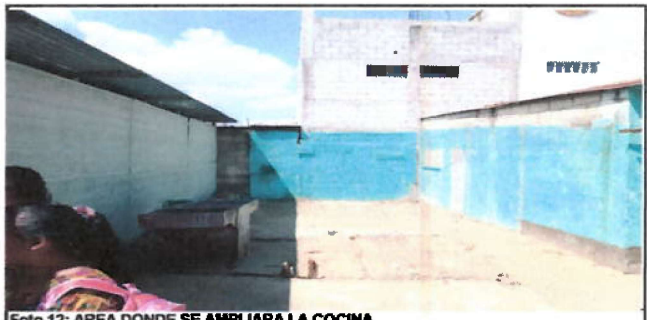
Foto 12: AREA DONDE SE AMPLIARA LA COCINA
