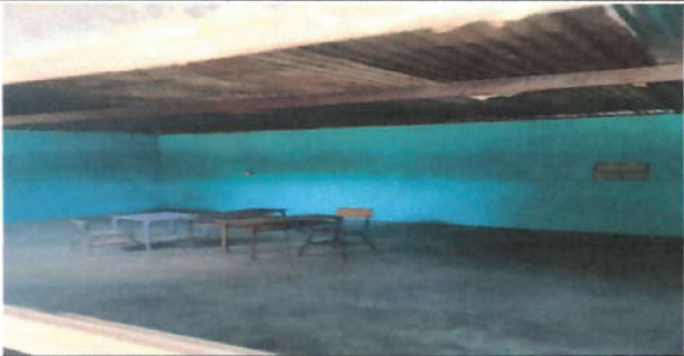
Foto 7: VISTA INTERIOR DE COCINA
