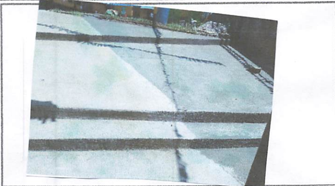
Foto 7: Patio: Nivelación entrada Principal.
