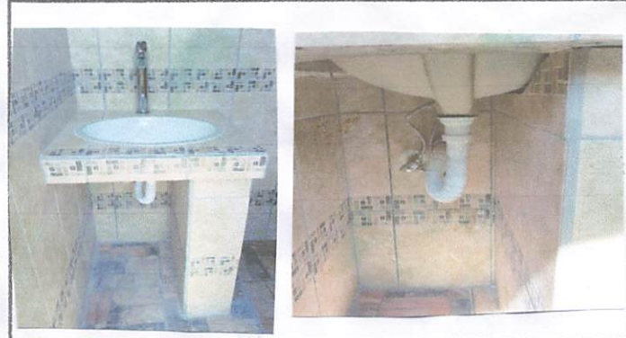
Foto 4: Lavamanos - en sanitarno de maestras, y drenaje.
