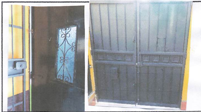
Foto 19: Pintura de puertas y portón color negro anticorrosivo.
