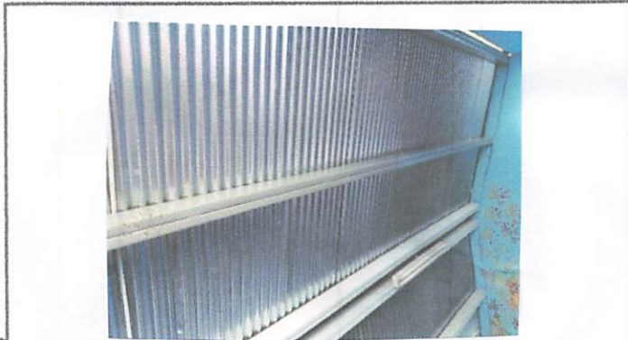
Foto 1: Colocación de lamina en un aula.
