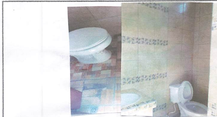
Foto 3: Piso: Colocación de azulejo en Sanitarno de maestras.
