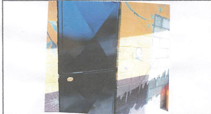
Foto 2: Ampliación, Anulación de puerta con un metro de levantado de Pared, repello.
