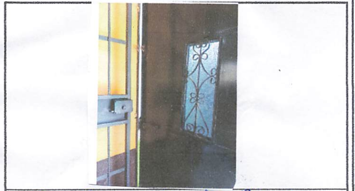
Foto 20: Reparación de puerta en bodega.
