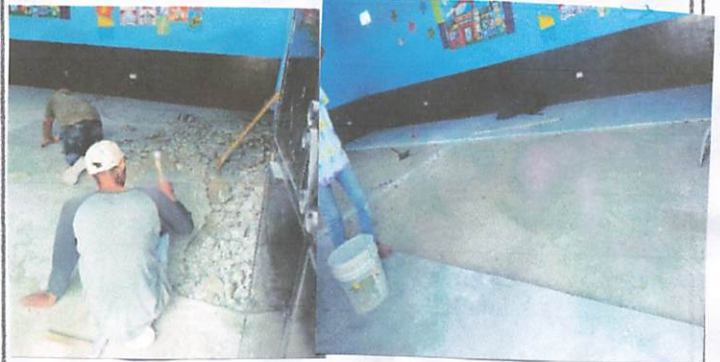
Foto 6: Piso: Trabajando en la colocación de piso cerámico.
