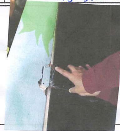
Foto 20: Reparación de Puerta
