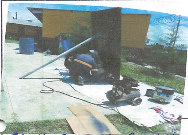
Foto 19: Pintura de Puertas
