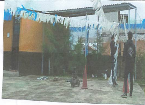
Foto 20: Fabricación de techo de estructura metálica.
