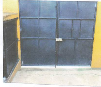
Foto 10: Demolición de torta y Fundición en entrada Principal.
