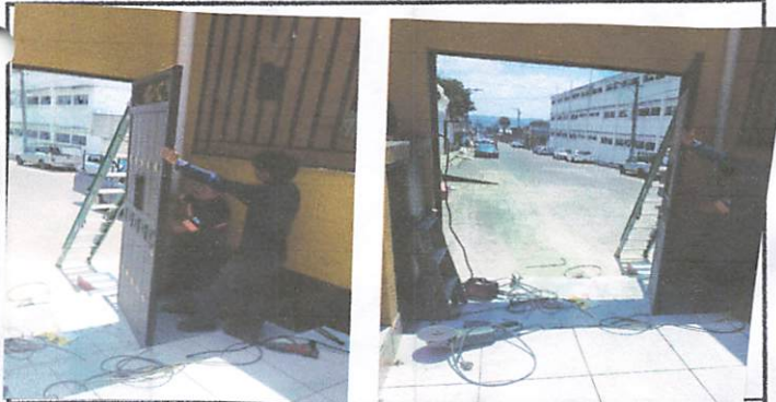
Foto 17: Fabricación e Instalación para Puerta entrada Principal
