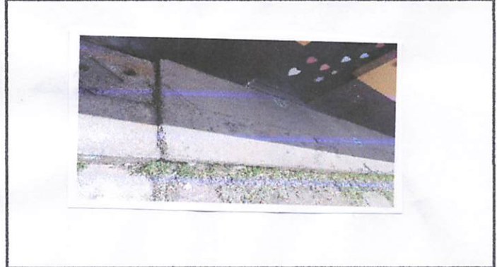
Foto 14: Banqueta frente a salones de clase se encuentra en mal estado, rajadas.
