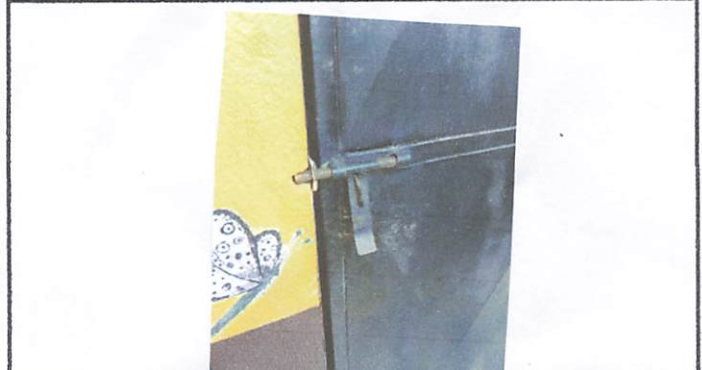
Foto 19: Pintura de Puertas y Porton
