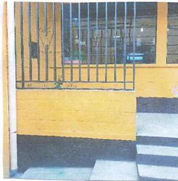
Foto 10: Demolicion de torta y fundición en entrada Principal.
