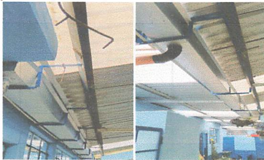
Foto3: canales y bajadas pluviales
