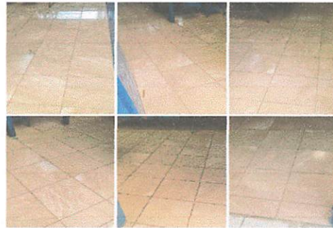
Foto 4 : 6 aulas para cambio de piso
