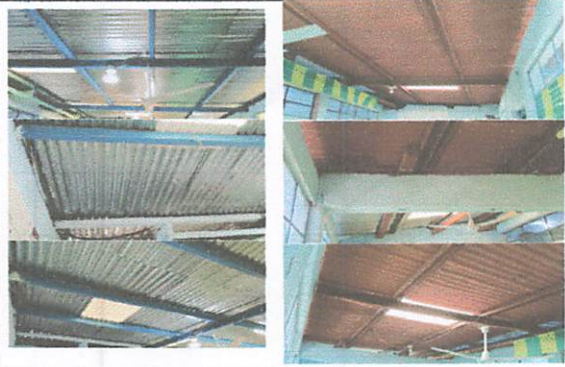
Foto 1 modulo de aulas
