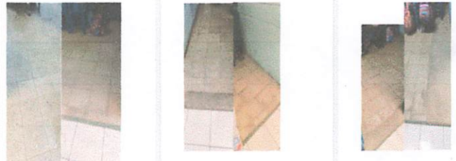
Foto 4 : 6 aulas para cambio de piso
