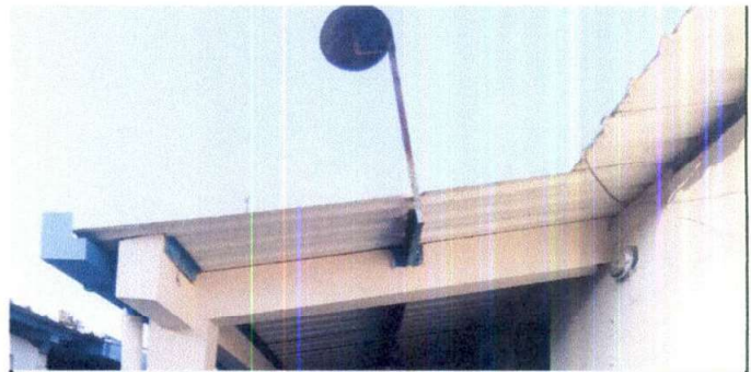
Foto 10: AREA DONDE SE IMPLEMENTARA LOSA ACERO
