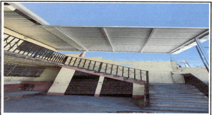
Foto 2: Techado de Laminas
