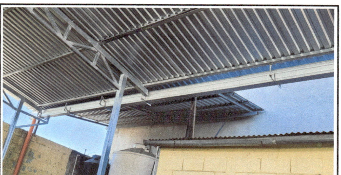
Foto 6: Canales para cancha
