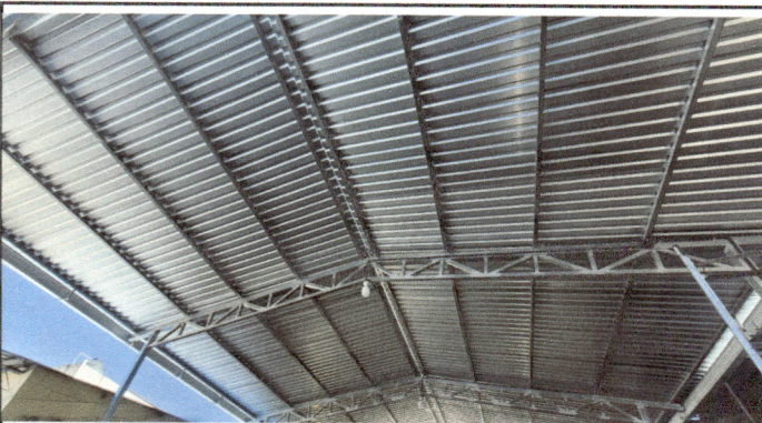
Foto 3: Techado de lamina en area de la cancha
