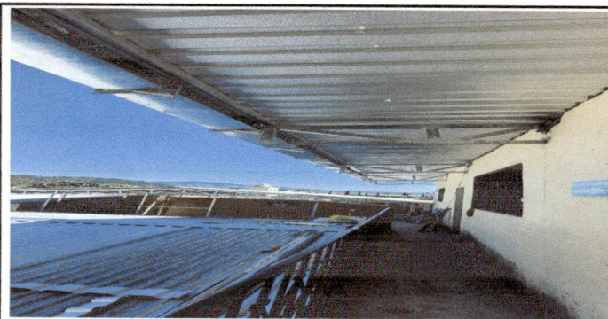
Foto 5: Ampliacion de Techado en el segundo Nivel
