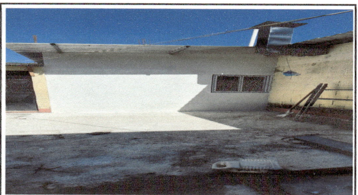
Foto 4: Instalacion de ventanas en cocina
