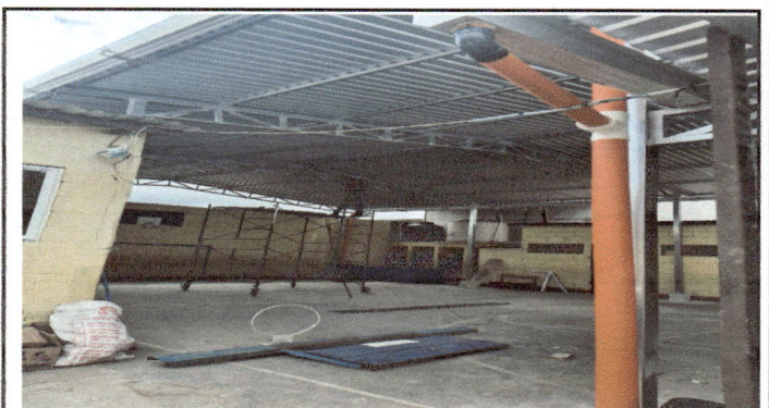
Foto 4: Instalacion de Lamina en techo
