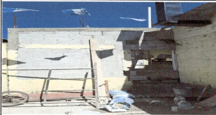
Foto 1: Ampliacion de cocina
