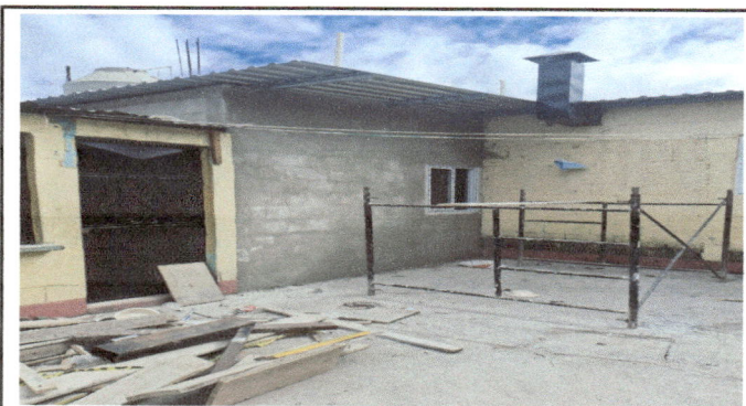
Foto 5: Ampliacion de Cocina
