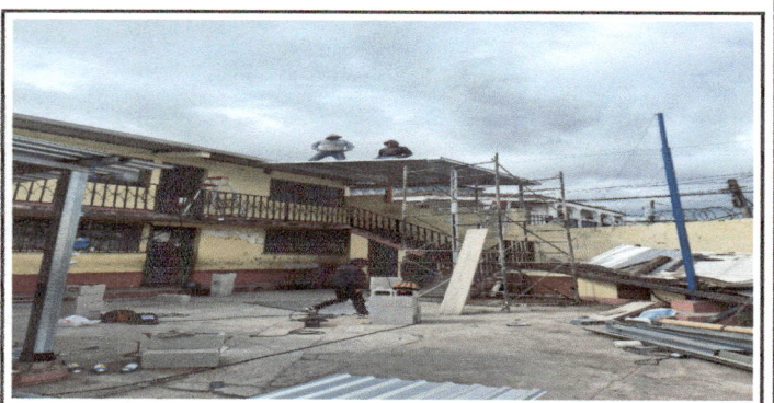
Foto 6: Ampliacion de Techo en gradas
