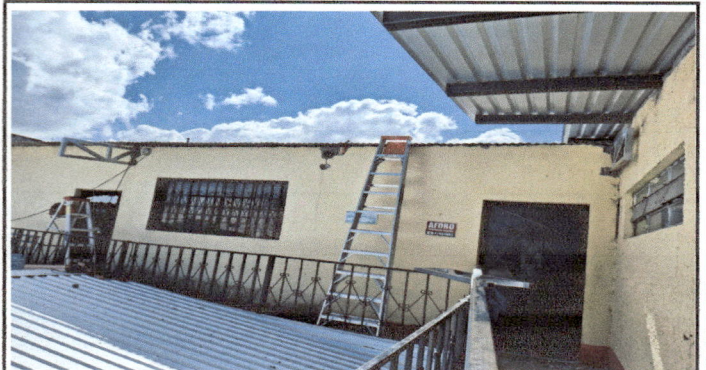
Foto 2: Ampliacion de Techo en Corredor
