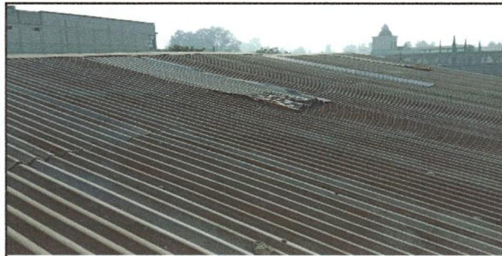
Foto 3: Laminas en mal estado de cancha
