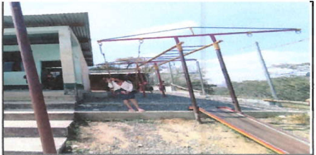
Foto 10: AREA DONDE SE IMPLEMENTARA ESTRUCTURA METALICA Y LAMINA TROQUELADA
