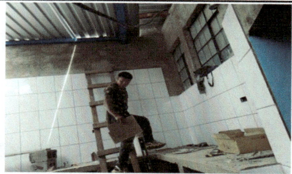
Foto 6: CONTRUCCION MUEBLE FIJO ÁREA DE COCINA
