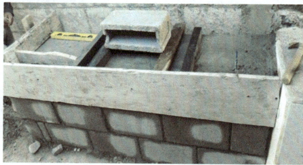
Foto 3: ELABORACIÓN DE PILETAS
