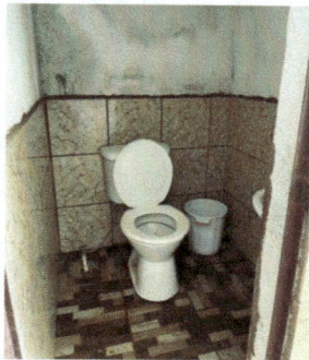
Foto 5: CAMBIO DE SANITARIOS
