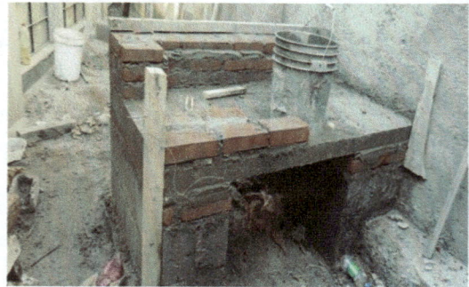
Foto 2: CONSTRUCCIÓN DE POYO
