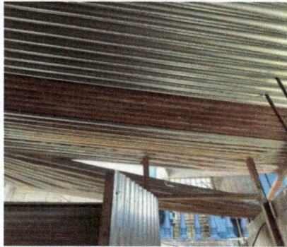
Foto 1: TECHADO ÁREA DE COCINA
