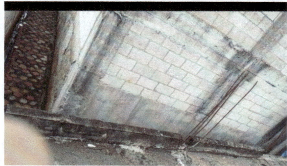
Foto 4: ELABORACIÓN DE MURO PERIMETRAL
