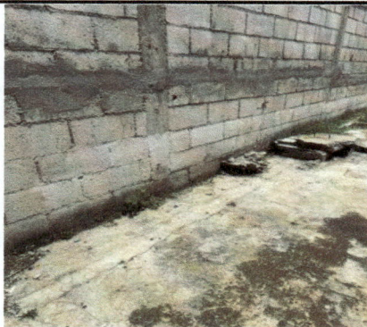
Foto 3: ELABORACIÓN DE PILETAS
