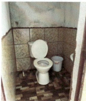
Foto 5: CAMBIO DE SANITARIOS
