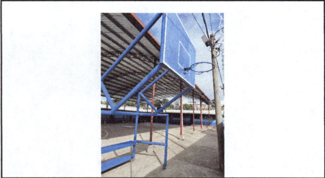
Foto 3: Reparación de porterías
