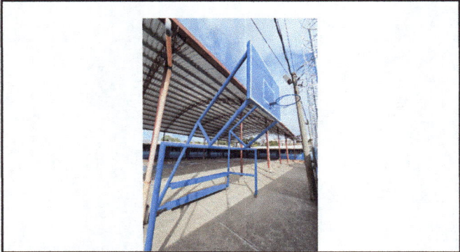
Foto 4: Reparación de porterías
