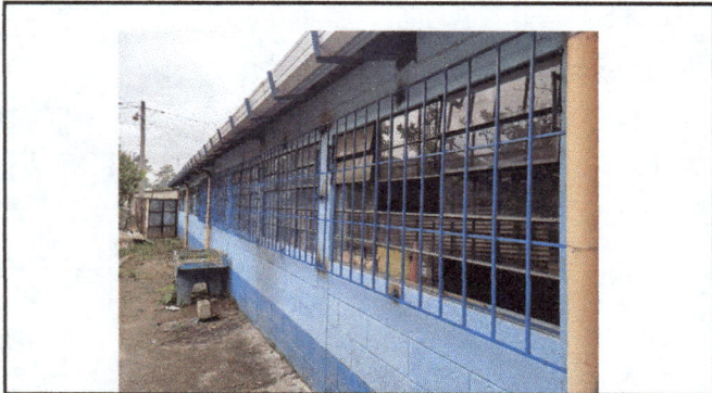
Foto 3: Colocación y terminación de balcones en los salones
