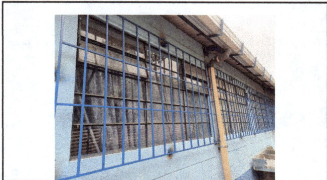
Foto 4: Colocación y terminación de balcones en los salones
