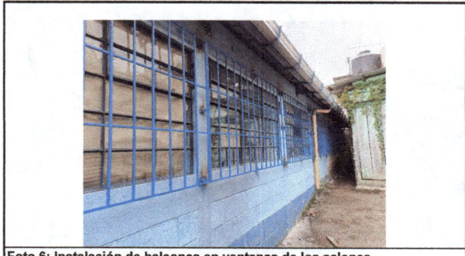
Foto 6: Instalación de balcones en ventanas de los salones
