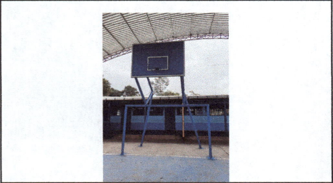
Foto 1: Reparación de porterías
