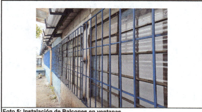
Foto 5: Instalación de Balcones en ventanas
