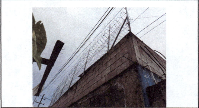
Foto 8: Instalación de Maya con alambre razor con electricidad
