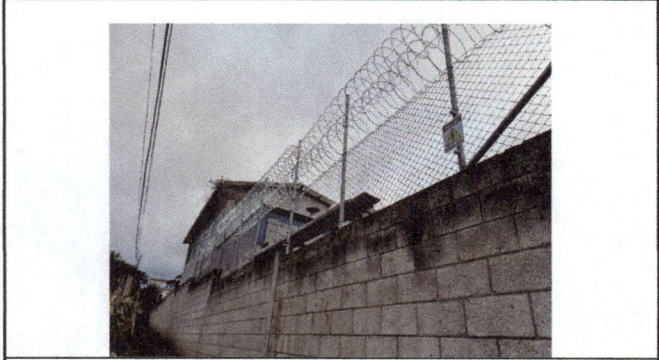
Foto 9: Instalación de Maya con alambre razor con electricidad
