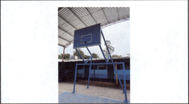
Foto 2: Reparación de porterías
