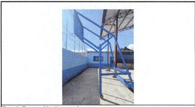
Foto 6: Reparación de porterías
