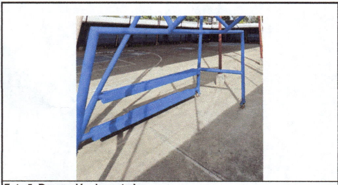
Foto 5: Reparación de porterías
