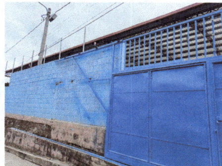
Foto 2: Terminación de colocación de reja.
