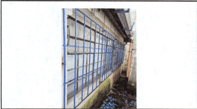
Foto 1: Colocación y terminación de balcones en el salón de dirección parte de atrás
