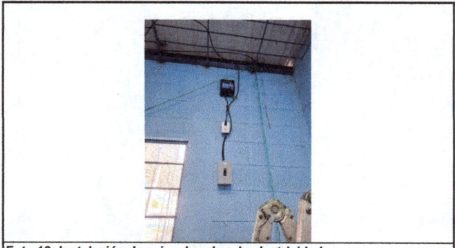
Foto 12: Instalación de caja y breaker de electricidad
