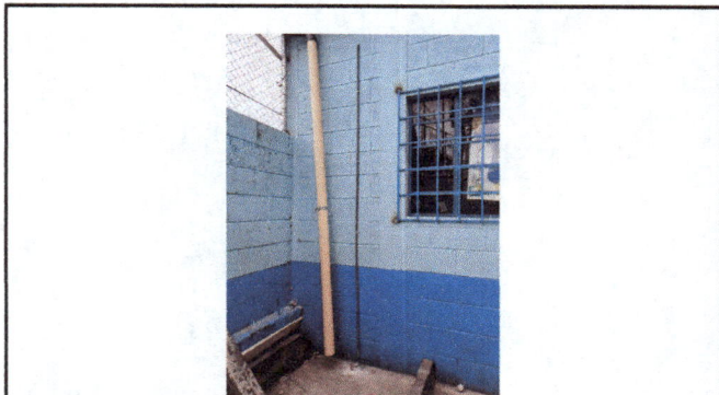
Foto 16 : Instalación de barilla de cobre
