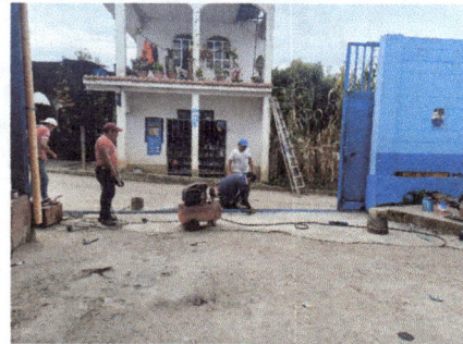
Foto 6: Reparación de riel del porton
