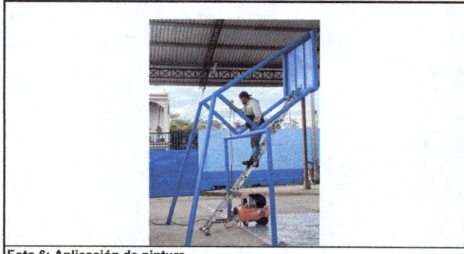
Foto 6: Aplicación de pintura
