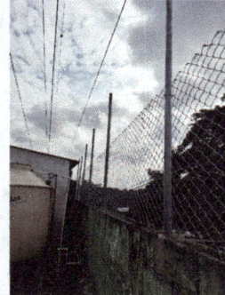
Foto 8: Colocación de maya parte de atrás del instituto
