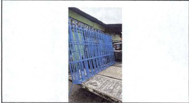
Foto 2: Traslado de balcones del taller hacia el instituto
