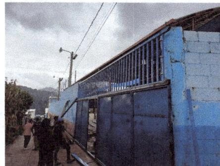
Foto 4: Colocación de reja superior
