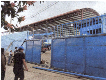
Foto 5: Colocación de guía principal con rodos
