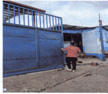
Foto 2: Reparación de riel del porton
