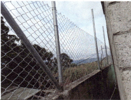
Foto 7: Instalación de maya parte de atrás
