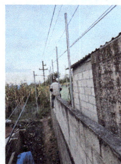
Foto 4 :Fundición de tubos para maya parte de atrás de la escuela
