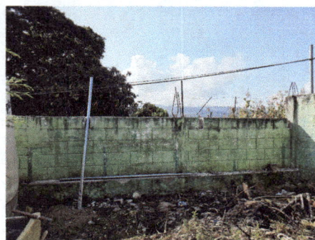
Foto 2: Colocación de tubos parte de atrás
