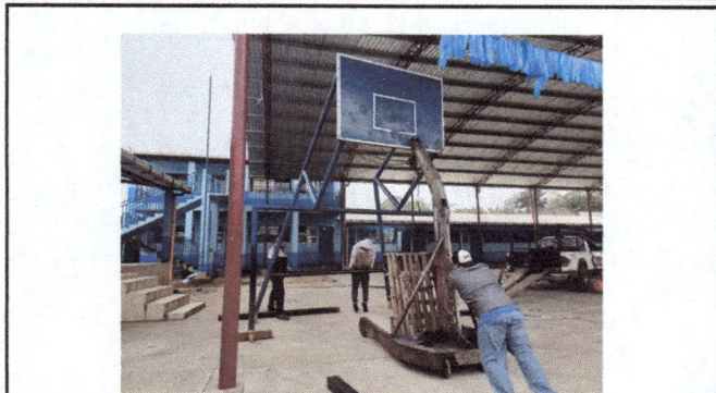
Foto 1: Reparación de porterías
