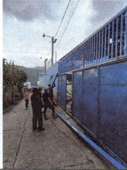
Foto 1: Reparación de porton principal
