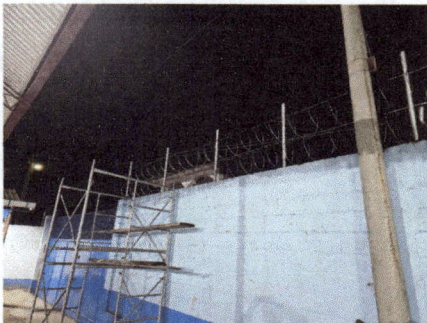
Foto 11: Instalación de razor
