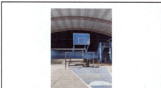
Foto 4: Reparación de porterías
