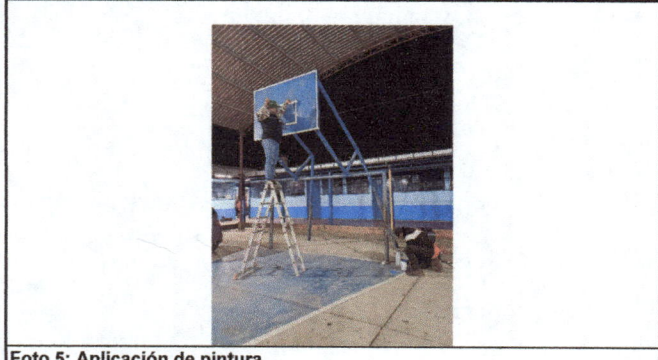
Foto 5: Aplicación de pintura
