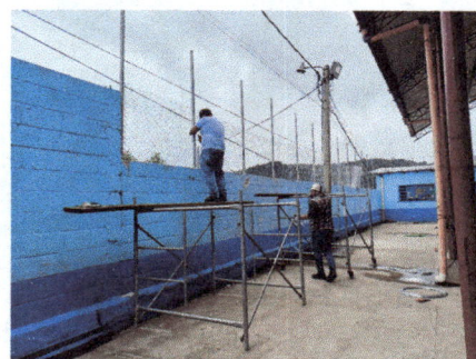
Foto 6: Instalación de maya
