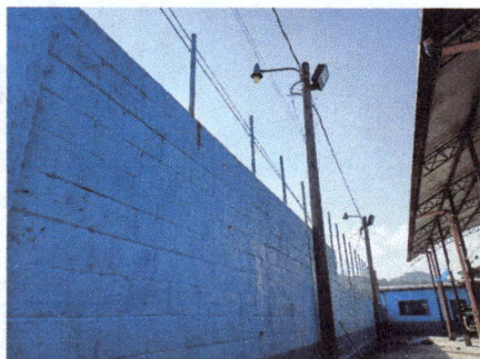
Foto 5: Instalación de tubos para maya
