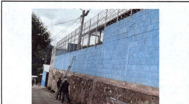
Foto 14: Colocación de aisladores de porcelana
