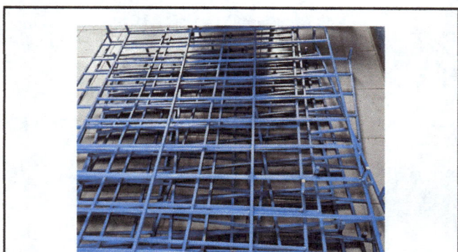
Foto 4 : Descarga de los balcones y resguardo en el salón
