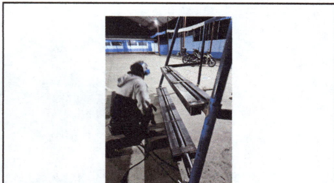
Foto 3: Instalación de contra peso
