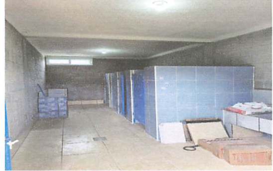
Foto 2: Instalación de zulejo en batería de sanitario para niños
