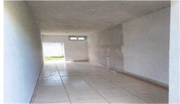
Foto 4: Instalación de piso en área de bodega
