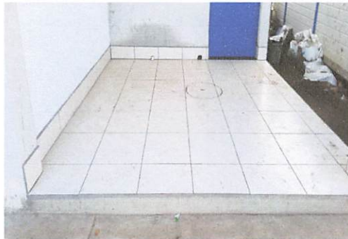
Foto 14: Instalación de piso en pasillo de cisterna
