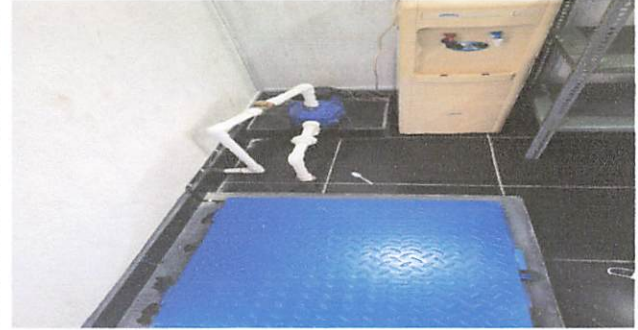
Foto 8: Instalación de bomba de agua en cisterna
