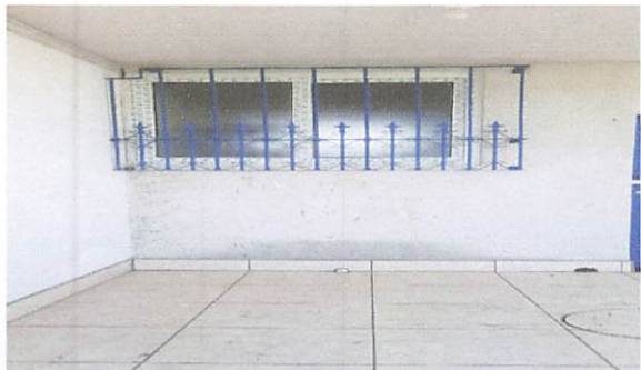
Foto 13 : Instalación de valcones en área de cisterna
