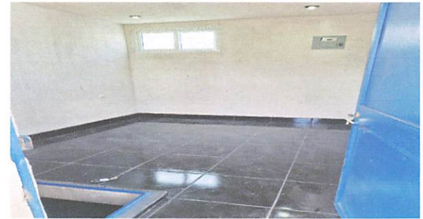
Foto 6: Instalación eléctrica en cisterna y batería de sanitarios
