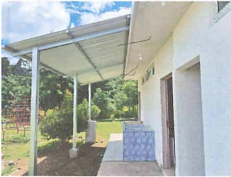
Foto 3: Levantado de muro y cernido en área de bodega
