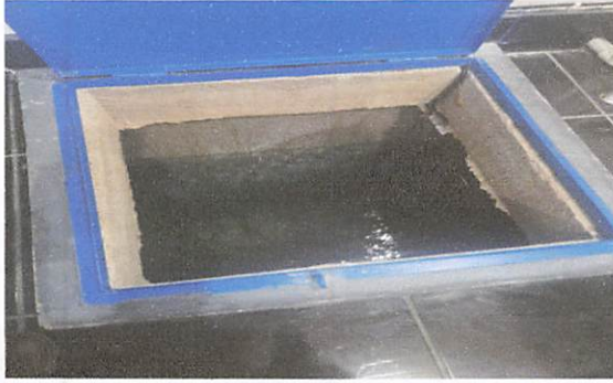
Foto 7: Instalación de tapadera en cisterna
