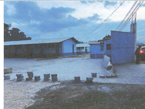
Foto 10: Instalación de acoquin en la entrada principal a preprimaria
