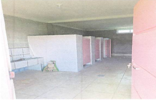
Foto 1: Instalación de azulejo en batería de sanitarios para niñas
