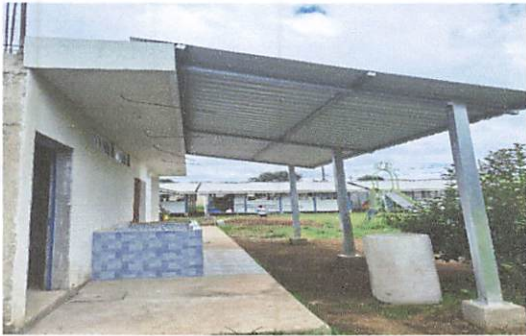
Foto 9: Techado de pila en frontispicio
