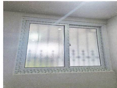
Foto 12: Instalación de ventanas en cisterna
