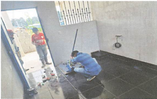
Foto 5: Instalación de piso en área de cisterna
