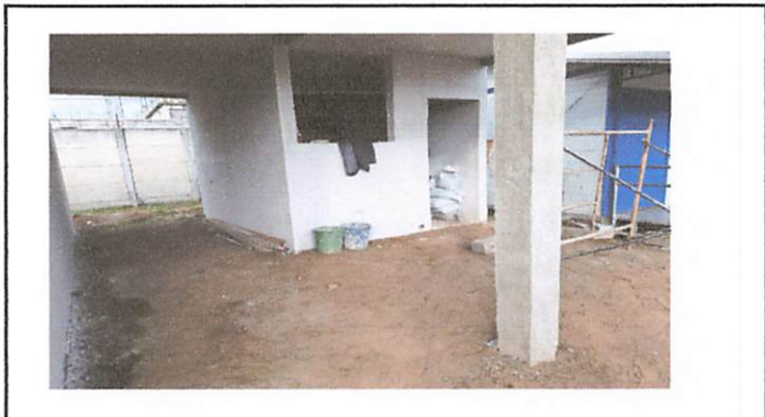
Foto 14: Instalación de piso en pasillo de cisterna.
