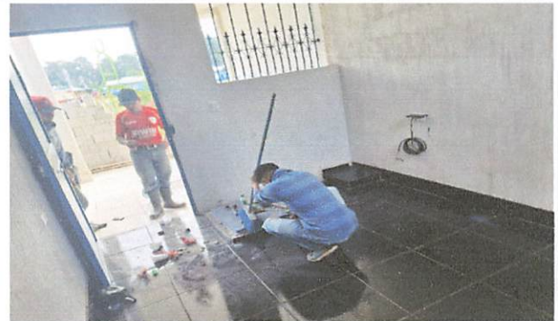
Foto 8: Instalación de bomba de agua en área de cisterna
