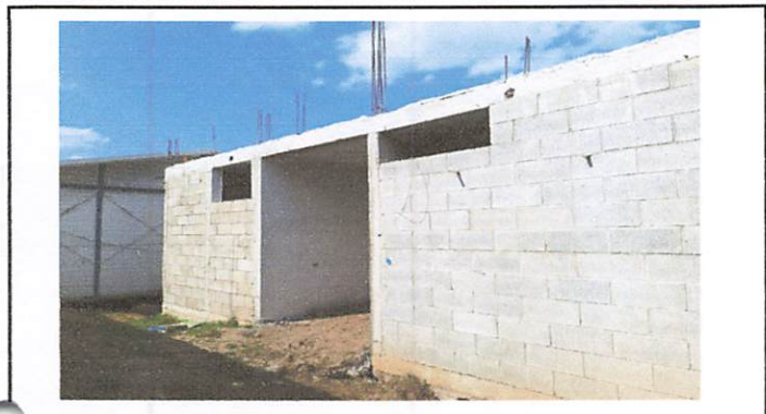
Foto 13: Instalación de valcon en áreas de cisterna
