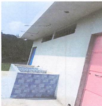
Foto 9: Techado de pila en frontispicio de batería de sanitarios
