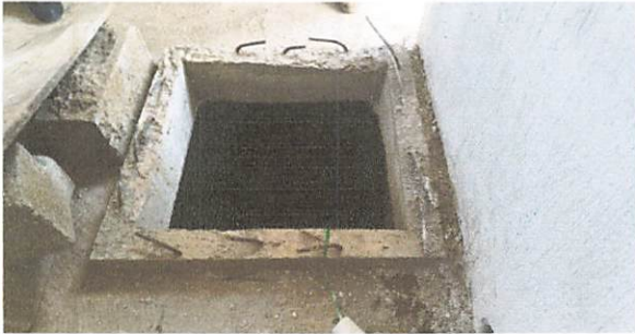
Foto 7: Instalación de tapadera en cisterna
