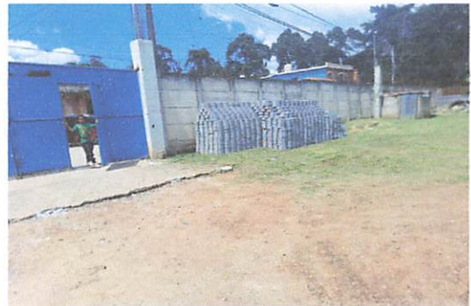
Foto 10: Instalación de adoquín en entrada principal a preprimaria.
