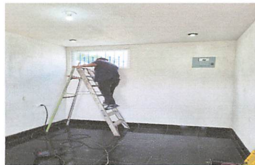
Foto 12: Instalación de ventanas en cisterna
