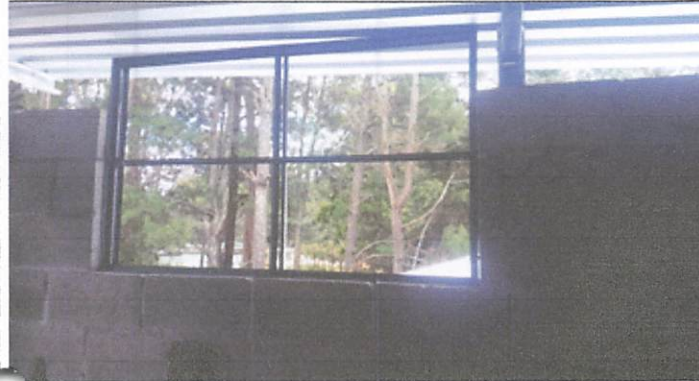
Foto 1: Techo en la bodega
