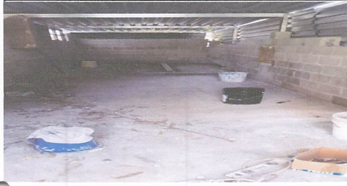
Foto 1: Techo en la bodega
