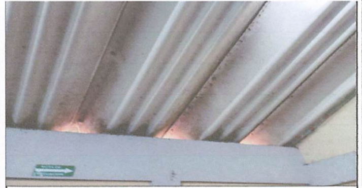
Foto 6: El Techo dentro del Laboratorio,
