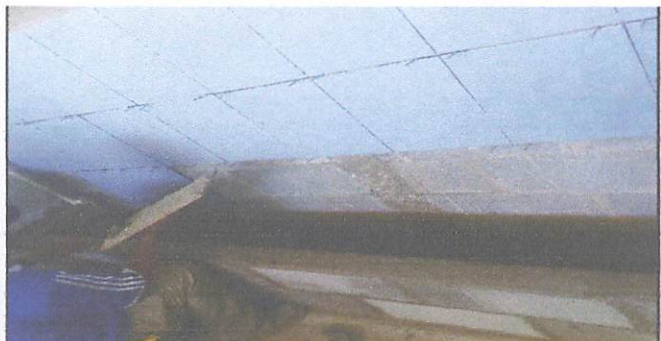
Foto 6: colocación de azulejo en el migitorio
