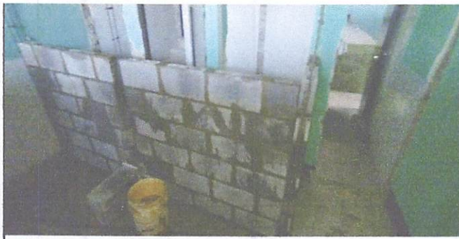
Foto 5: colocación de pared para el migitorio
