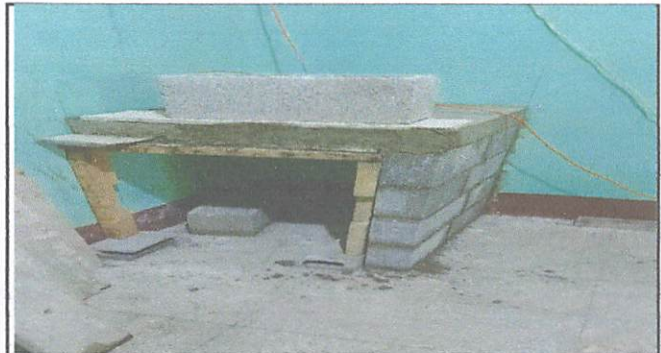
Foto 2: Elaboración de mesa de concreto en la cocina
