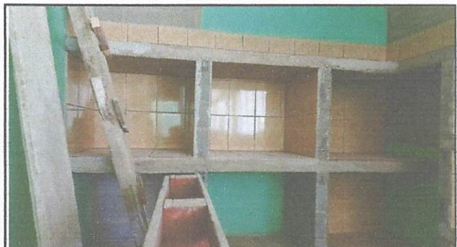
Foto 4: colocación de azulejo en la repisas de la cocina
