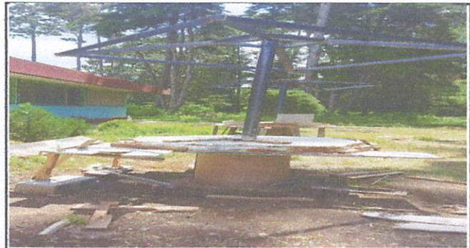
Foto 4: Elaboracion de la estructura para techo de las mesas
