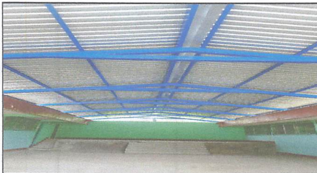
Foto 3: colocacion de alumbrado en el salon de usos multiples
