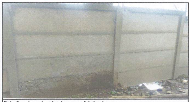
Foto 6: colocación de placas prefabricadas
