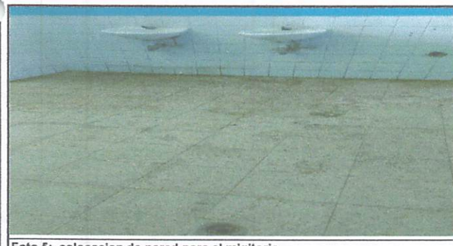
Foto 5: colocación de pared para el migitorio
