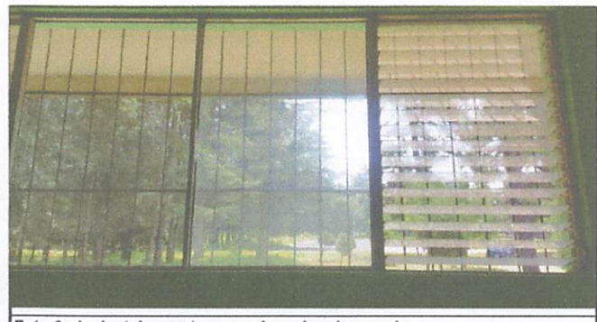
Foto 6: desinstalar ventana y colocacion de pared
