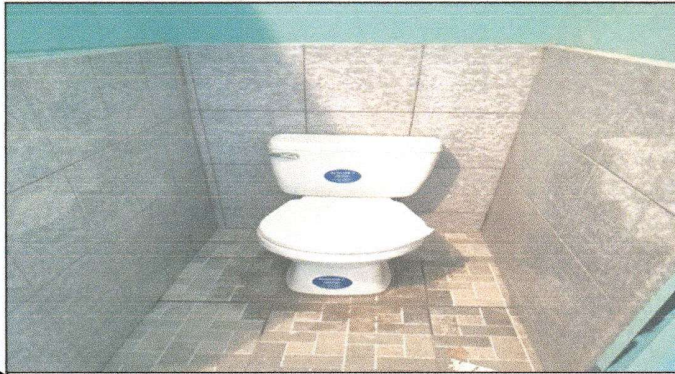
Foto1: Cambio de inodoros y lavamanos con pedestal.
