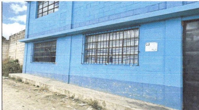
Foto 3: Colocación de balcones en las ventanas del primer nivel.
