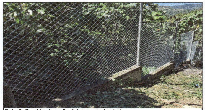
Foto 6: Cambio de malla del muro perimetral.
