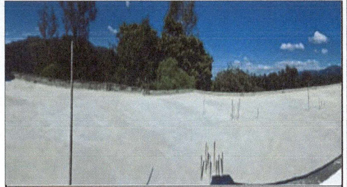
Foto 2: Impermeabilizar terraza segundo nivel.
