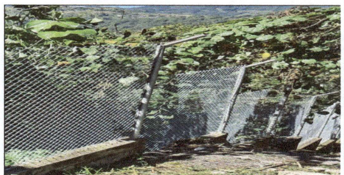
Foto 6: Cambio de malla del muro perimetral.
