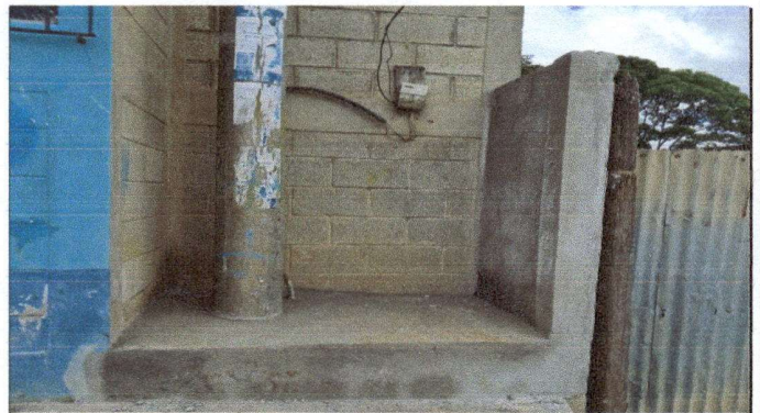
Foto 4: Levantado de muro y fundición de banqueta y colocación de baranda.
