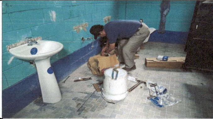
Foto 1: Cambio de inodoros y lavamanos con pedestal.
