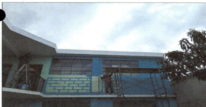
Foto 5: Aplicando pintura en cenefa y corredor de aulas del segundo nivel.
