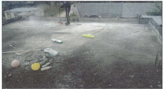
Foto 2: Limpieza de terraza con cepillo de alambre y cepillos tipo escoba.
