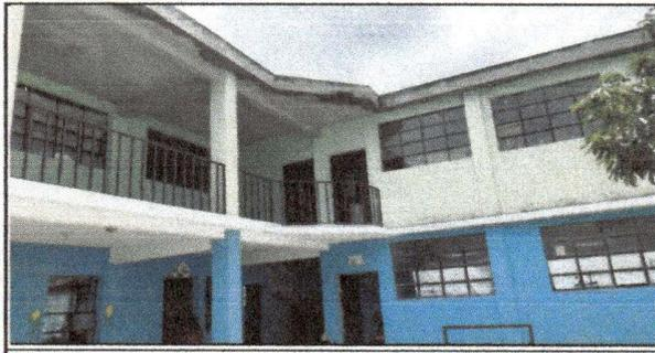
Foto 5: La pintura del segundo nivel se encuentra en mal estado
