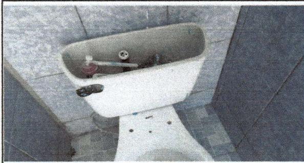
Foto 1: Servicios sanitarios con accesorios en mal estado por lo que no se puede suministrar agua de manera correcta.
