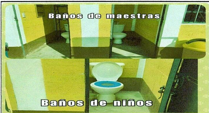
MEJORAMIENTO EN LA COLOCACIÓN DE PISO Y AZULEJADO EN BAÑOS DE MAESTRAS Y BAÑOS DE LOS ALUMNOS.
