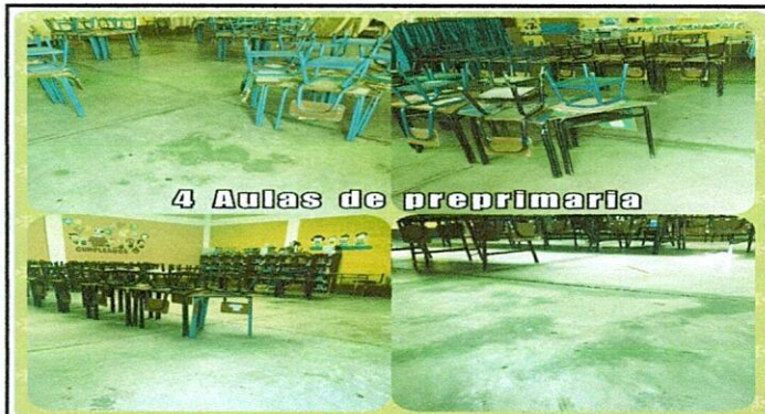
MEJORAMIENTO EN AULAS CON LA COLOCACIÓN DE PISO PARA 4 SALONES.
