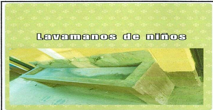
MEJORAMIENTO EN LAVAMANOS DE NIÑOS CON LA COLOCACIÓN DE AZULEJO.
