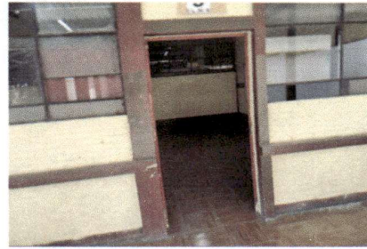
Foto 2: Cambio de piso Aulas 4-10
