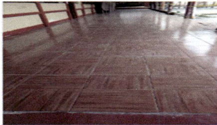
Foto 3: Cambio de piso corredor
