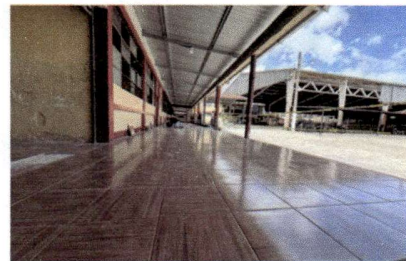
Foto 6: Cambio de piso corredor
