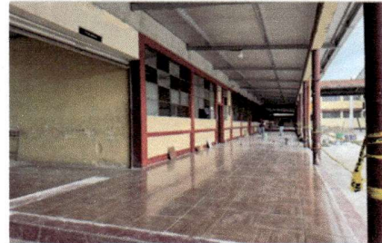
Foto 4: Cambio de piso corredor
