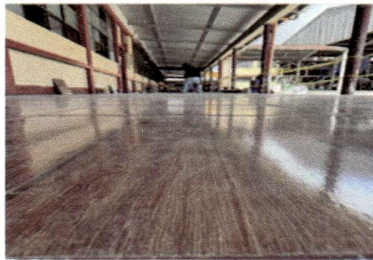
Foto 5: Cambio de piso corredor
