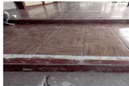
Foto 6: Cambio de Piso Corredor
