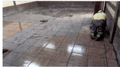
Foto 4: Cambio de Piso Aulas 4-10
