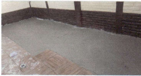
Foto 1: Cambio de piso Aulas 1-3
