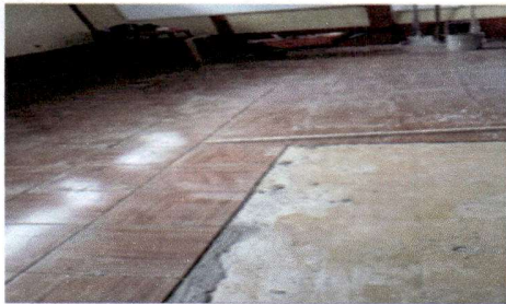
Foto 3: Cambio de Piso Aulas 4-10
