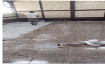
Foto 2: Cambio de piso Aulas 1-3
