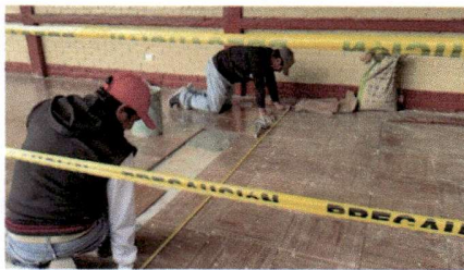
Foto 5: Cambio de Piso Corredor
