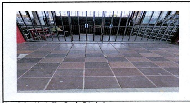
Foto 5: Cambio de Piso Portón Principal
