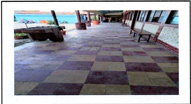
Foto 4: Cambio de piso Aulas Administrativas
