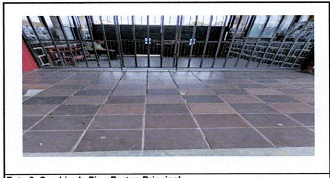
Foto 6: Cambio de Piso Porton Principal
