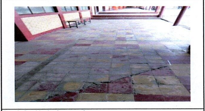
Foto 2: Cambio de piso corredor
