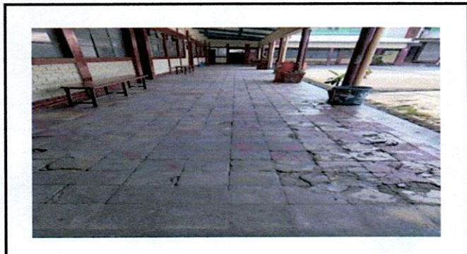
Foto 3: Cambio de Piso Aulas 1 -3
