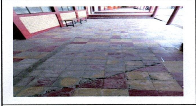
Foto1: Cambio de piso Aulas 4 -10
