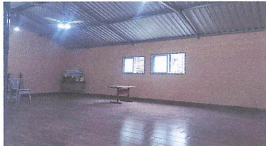
Foto 6: SALON TERMINADO CON VENTILAR, VENTANAS, PISO Y ENERGIA ELECTRICA
