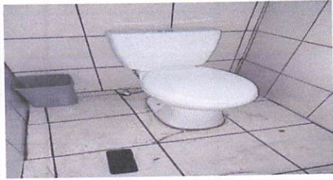
Foto1: CAMBIO DE BAÑOS
