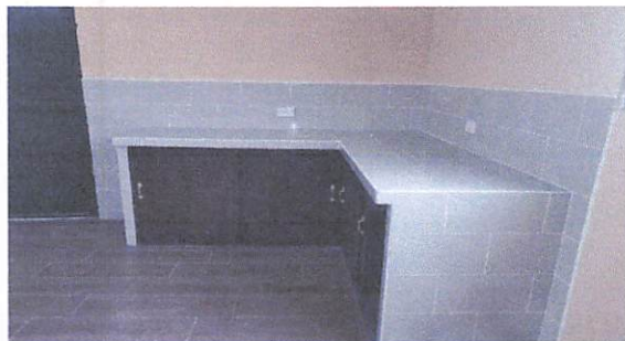
Foto 3: GABINETES CON PUERTAS Y AZULEJO SE DEJARON CONEXIONES DE TOMACORRINETES
