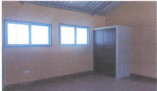
Foto 1: REPELLO, PINTURA DE COCINA, VENTANAS, BODEGA CON AZULEJO Y PUERTA
