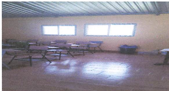
Foto 2: SALON DE ORIENTACION, PISO, VENTANAS, ENERGIA ELECTRICA, VENTILADORES Y PUERTA NUEVA
