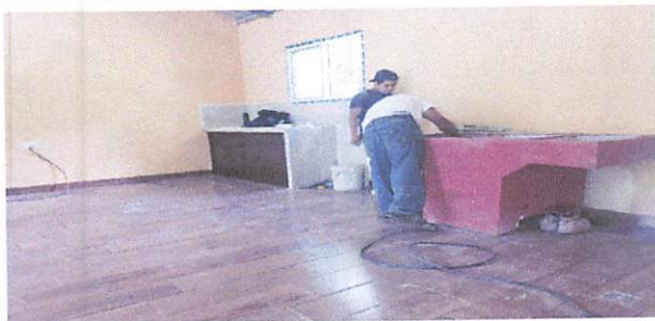
Foto 5: COLOCACION DE PILA Y DRENAJE
