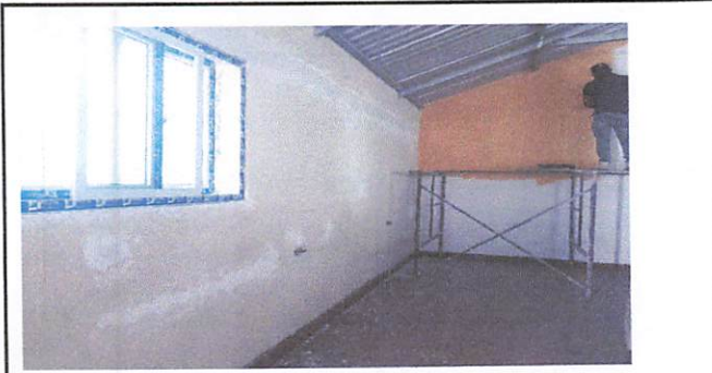
Foto 1: REPELLO Y PINTURA DE COCINA Y SALON
