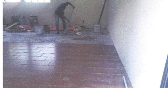
Foto 2: COLOCACION DE PISO EN COCINA Y SALON
