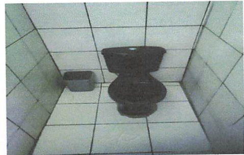
Foto 6: CAMBIO DE BAÑOS
