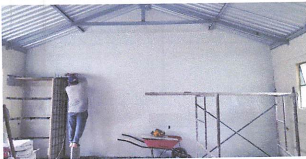
Foto 3: BODEGA CON PUERTA DE METAL
