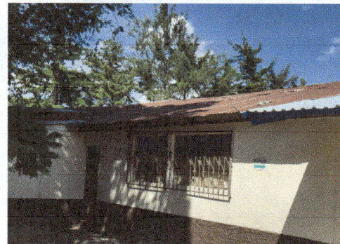
Foto 6: remozamiento relacionado al cambio de techo, bigas, sistema eléctrico de aula de educación especial.
