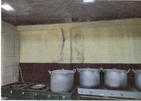
Foto 1: remozamiento de pared por filtración de agua en cocina.
