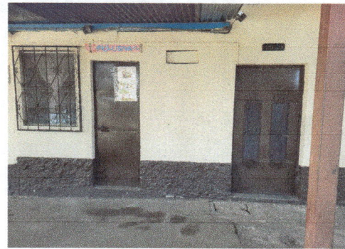
Foto 4: unión de cocina y aula de educación integrada para ampliación de cocina a través de la puerta mencionada en la foto 3.
