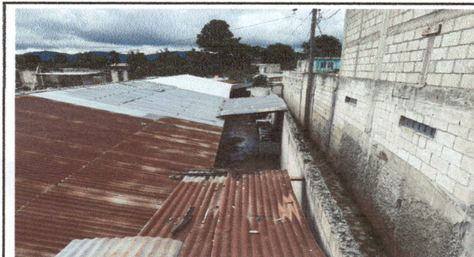
Foto 3: Implementación de techado en el corredor vacío
