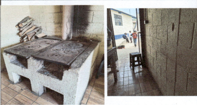
Foto 1: COCINA. Cambio de planchas, reparación de bases, cambio de chimenea y colocación de azulejo en paredes.
