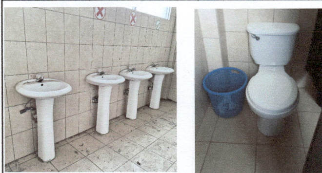
Foto 3: Baños del primer y segundo nivel: reparación de lavamanos, cambio de accesorios en los sanitarios y mijitorios.
