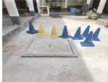
Foto 2: Colocación de tapadera de la cisterna.
