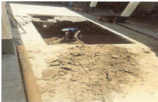
Foto 5: Zanjeo donde irá la cisterna.
