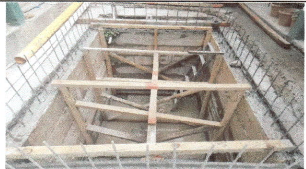
Foto 6: Fundición de cisterna.
