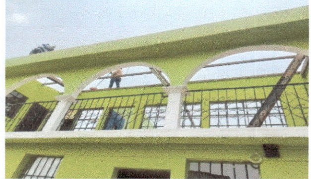
Foto 2: Lijado y pintura de costaneras.
