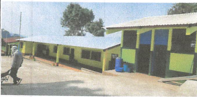
Foto 3: Instalacion de Laminas
