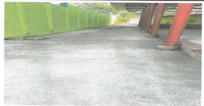
Foto 4: colocacion de pavimento
