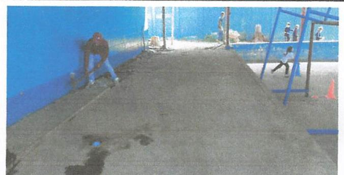
Foto 4: Levantamiento de pavimento para la alineacion de escenario
