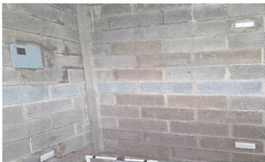
Foto 11: Instalaciones de cajas eléctricas ya concluidas.
