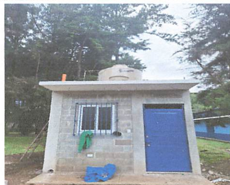
Foto 10: Bodega ya finalizada con todos sus accesorios.
