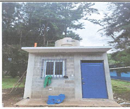
Foto 8: Tinaco Rotoplast ya instalado con todos sus accesorios.
