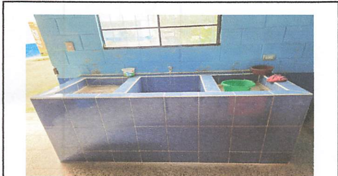
Foto 3: Pila fundida y con azulejo concluida.
