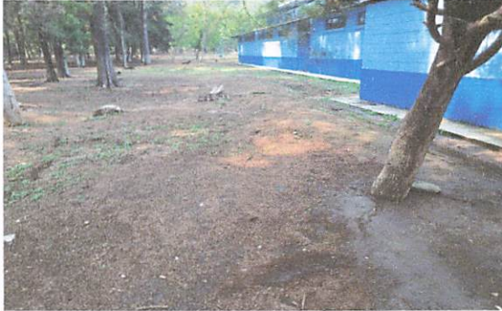
Foto 1: Área para construcción de cisterna subterránea 3X3X2.50 metros cúbicos
