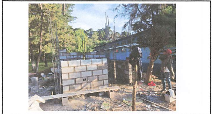
Foto 10: Realización de bodega de 3.20x3.20x3.03 metros
