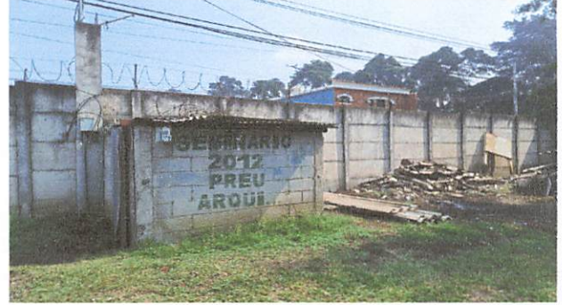
Foto 2: Toma de energía eléctrica para instalación de bomba.
