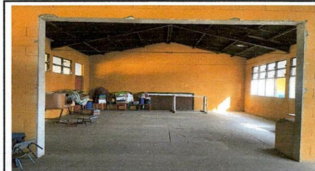
MEJORAMIENTO DE COMEDOR Y COCINA, HABILITAR VENTANA PARA SERVIR LOS ALIMENTOS, TECHO VENTANAS Y ENERGIA ELECTRICA
