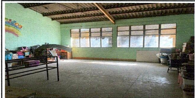
MEJORAMIENTO DE COMEDOR Y COCINA, HABILITAR VENTANA PARA SERVIR LOS ALIMENTOS, TECHO VENTANAS Y ENERGIA ELECTRICA
