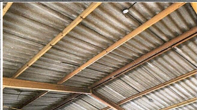
MEJORAMIENTO DE TECHO CORREDOR EXTERNO DEL COMEDOR Y COCINA
