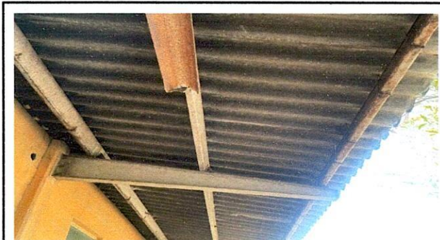
CAMBIO DE TECHA CORREDOR DE LA COCINA Y COMEDOR
