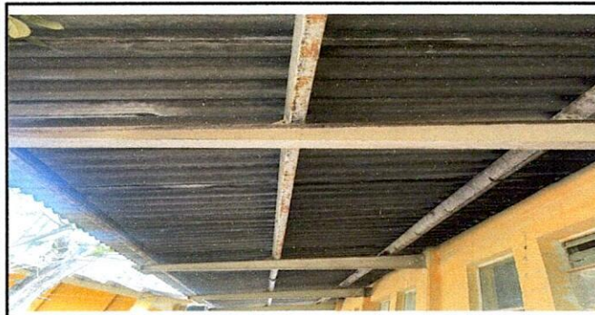
CAMBIO DE TECHA CORREDOR DE LA COCINA Y COMEDOR
