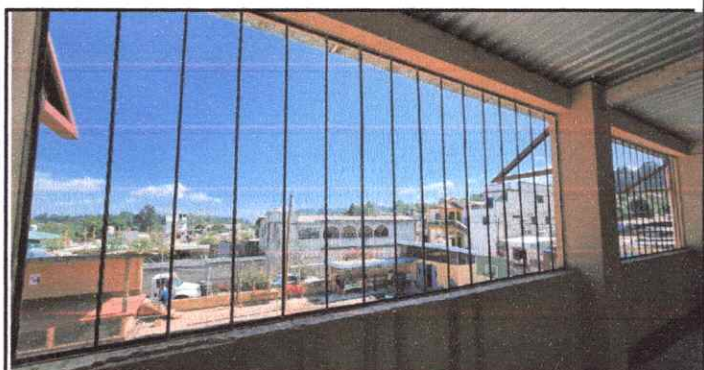
Foto 6: REPARACIÓN DE BARANDA DE SEGUNDO NIVEL
