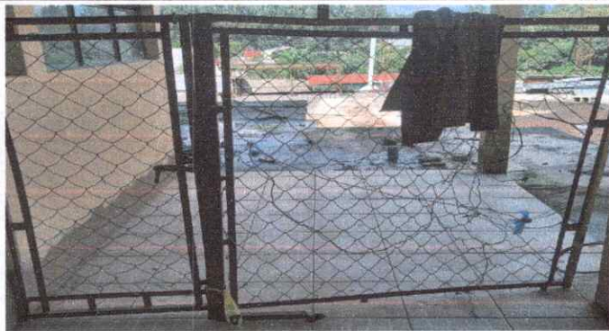
Foto1: FABRICACION E INSTALACION DE PUERTA
