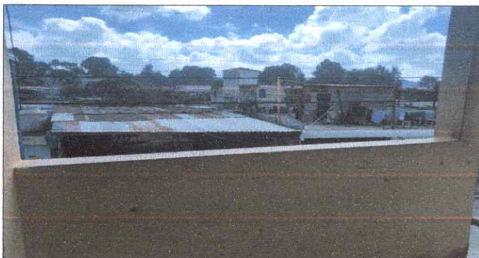
Foto 3: FABRICACIÓN E INSTALACION DE BARANDAS
