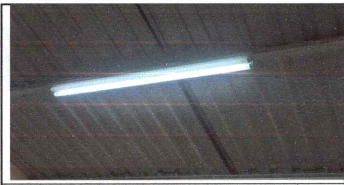
Foto 5: INSTALACION DE CAMBIO DEL SISTEMA DE ILUMINACIÓN A,B,C,D Y CORREDOR
