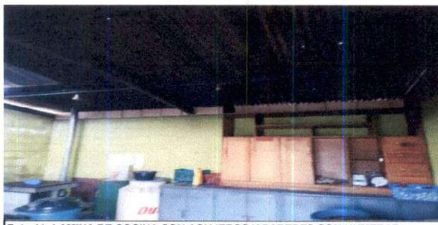
Foto 11: LAMINA DE COCINA CON AGUJEROS Y PAREDES CON HUMEDAD.
