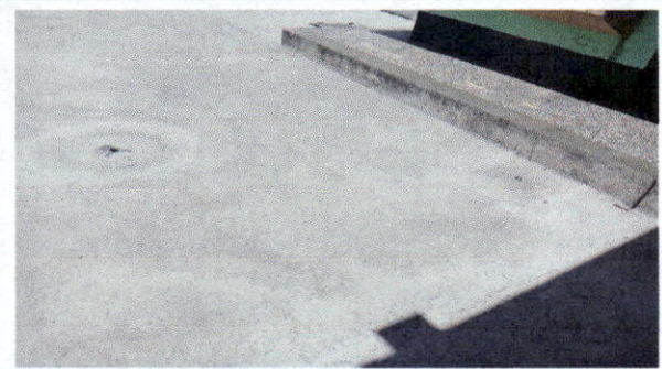
Foto 4: cajas de registro de patio en buen estado
