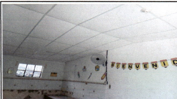
Foto 3: Colocación de cielo falso en aulas
