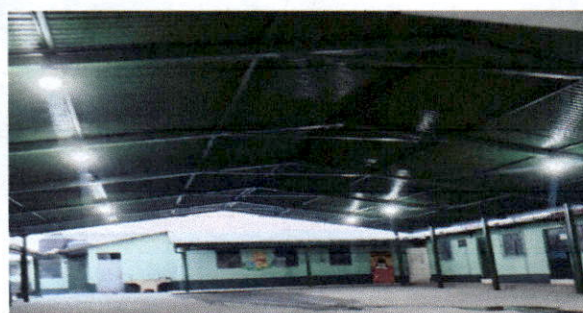
Foto 2: Techo y parales pintadas
