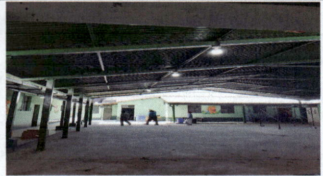
Foto 2: Instalaciones de nuevo cableado eléctrico en patio
