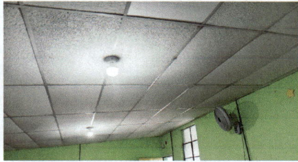
Foto1: Instalaciones nuevas de cableado y alumbrado en aulas
