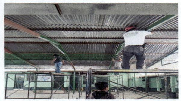
Foto 2: Pintura de parales y techo de lámina
