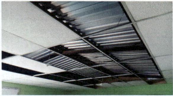
Foto 1: mantenimiento y colocación de el cielo falso esta en mal estado e instalación de cielo falso completo en 2 salones
