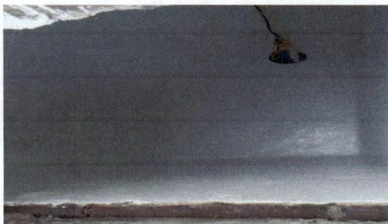
Foto 3: Arreglo e impermeabilizante de cisterna
