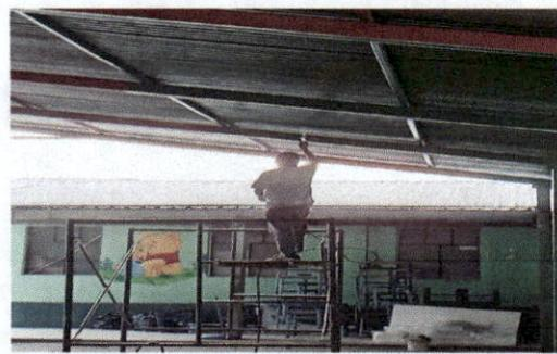
Foto 3: pintura de parales y techo de lámina
