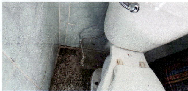
Foto 5: Reparacion de sanitarios
