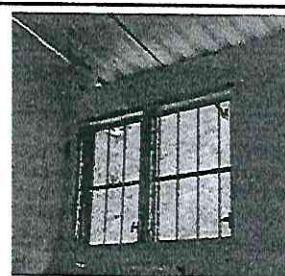
Foto 6: Sustitución de vidrio de ventana de 1.40x90
