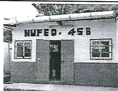
Foto 4: Fabricación e instalación de 2 balcones de hierro en ventanas, en vano de aula por falta de ventilación
