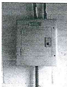
Foto 3: Sustitución de tablero de 4 flujos
