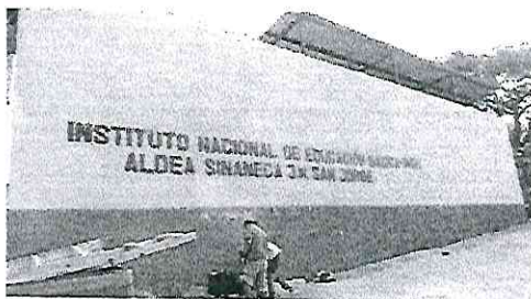
Foto 18: Pintura en exteriores.
